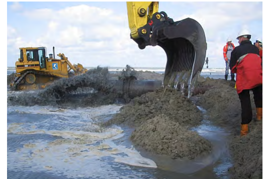
Start aanleg Maasvlakte 2
